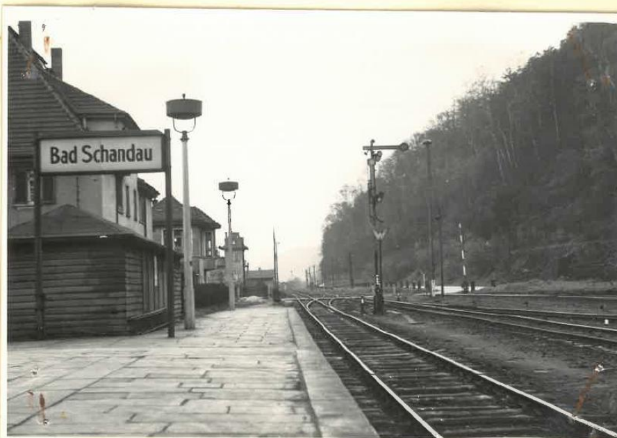
Blick auf Bahnsteig 2 in Richtung CSSR
